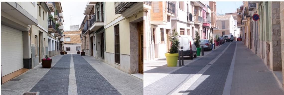
Adoquinado de calle y renovación de red de agua potable, pluviales y alumbrado público. Fuente: Ayuntamiento
